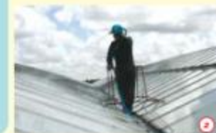
Utiliser un déambulateur pour le nettoyage des chéneaux
